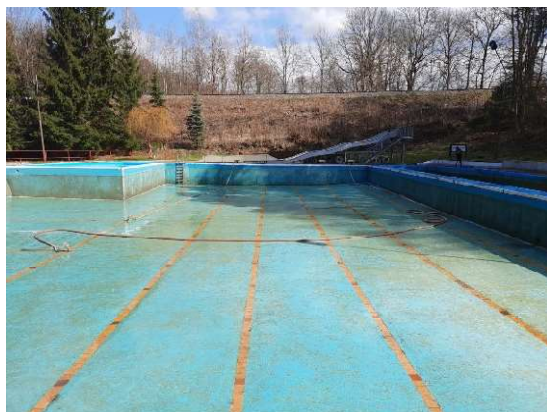
Das Schwimmbecken nach der Reinigung.
