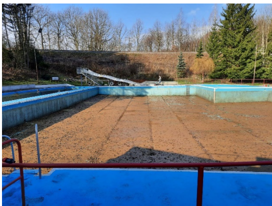
Das Schwimmbecken nach dem Ablassen des Wassers. Fotos: Steffen Schmidt
